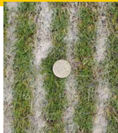
De sleufjes van 3 mm breedte, opgevuld met zand, rijafstand 4 cm. Andere afstanden en dieptes zijn ook mogelijk.
