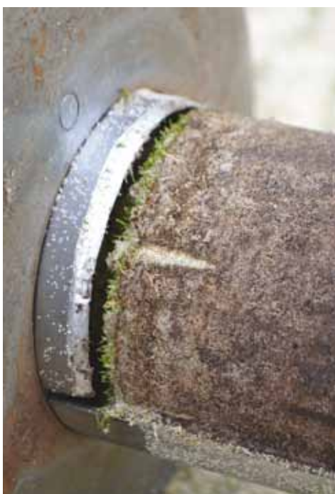
Controle of de sleufjes keurig gevuld zijn met zand.
