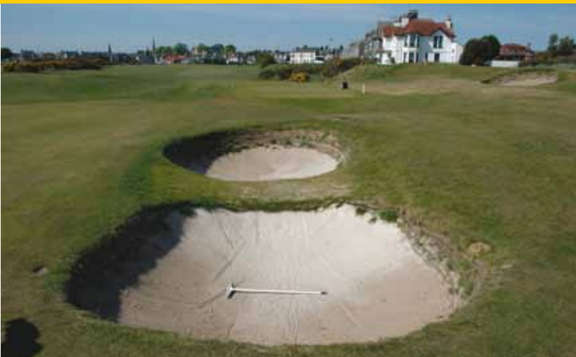
Geen drainage in de bunkers.
