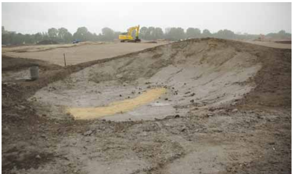
Er worden verschillende bunkertypes aangelegd.
