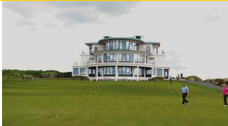
Er is een prachtig clubhuis, gebouwd in een soort art deco-stijl, met uitzicht rondom.
