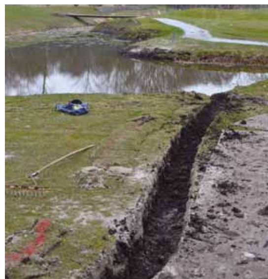
Blootgelegd profiel bij het graven van een drainagesleuf op een green
