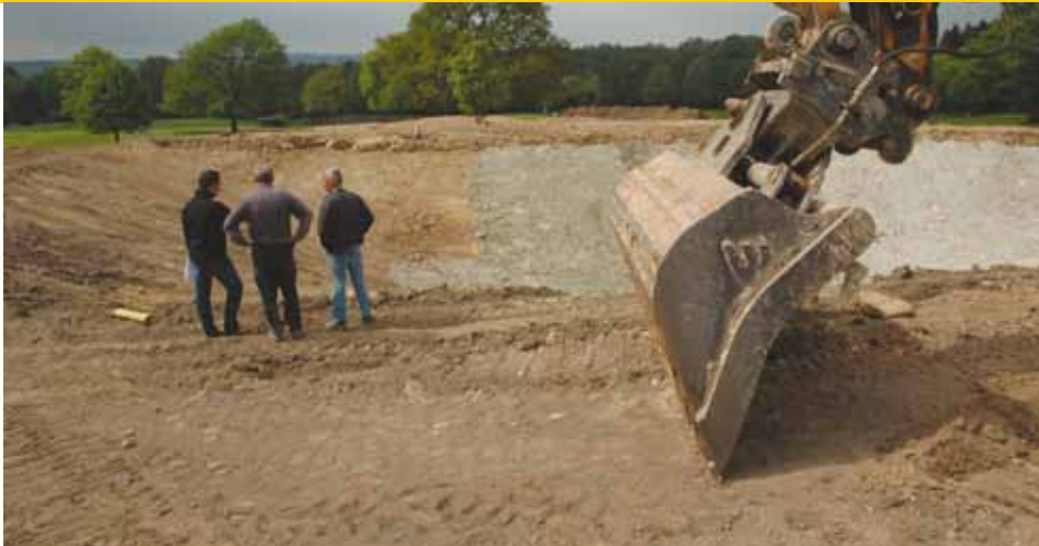
Een deel van de leemlaag is aangebracht in de zuidelijk vijver.
