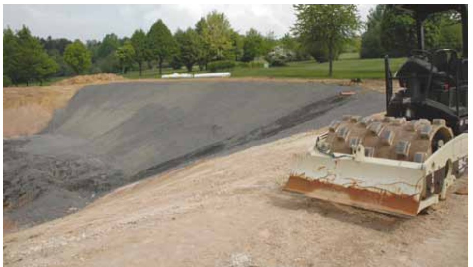
Op de voorgrond de blokwal waarmee Aha de Man de leemlagen verdicht. Vergelijk de wals met het principe waarmee schapen het keileem van een polderdijk met hun pootjes aanstampen.
