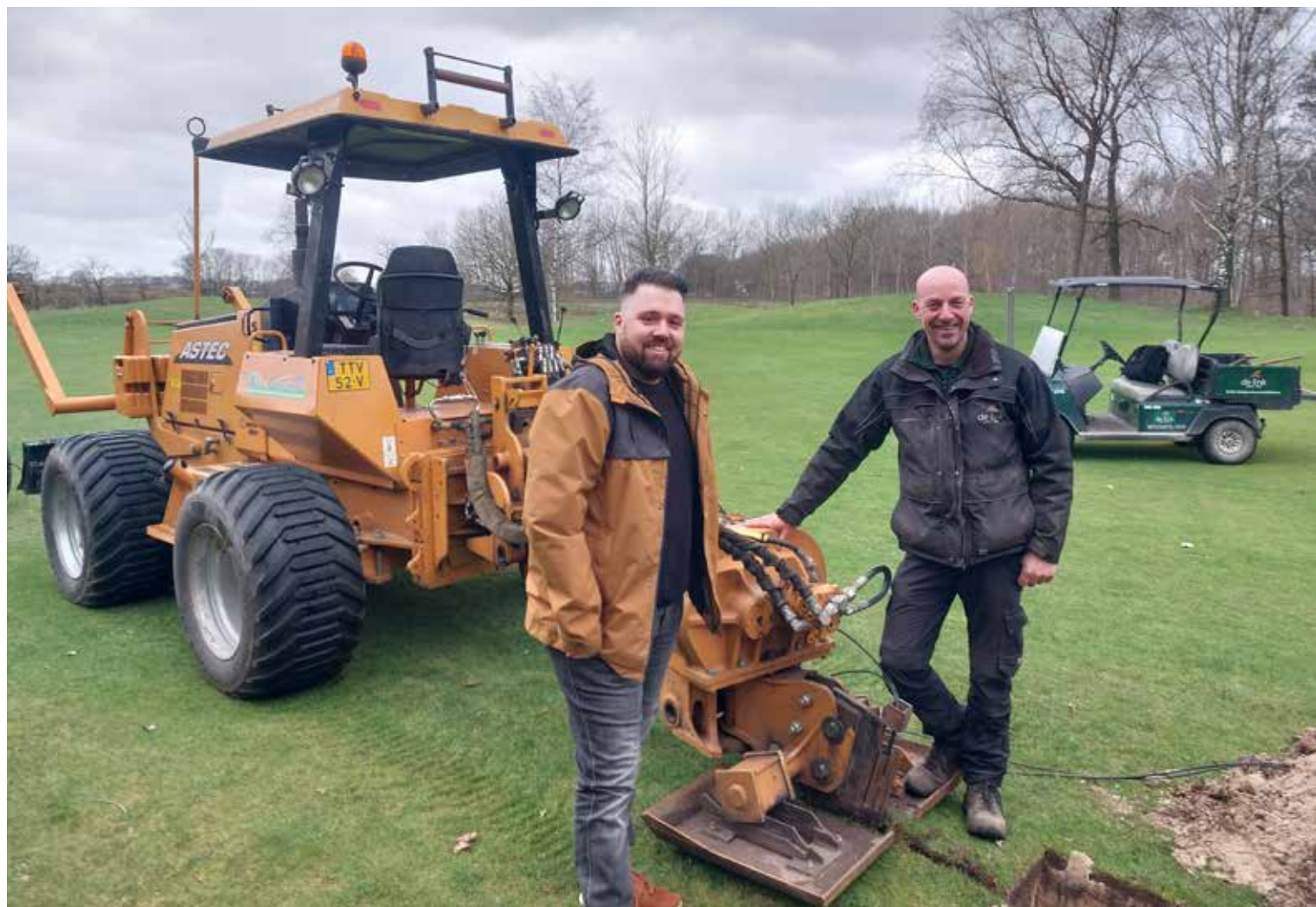
Johan Laurijsen (l) en Jeroen Vingerhoets bij de machine die een smalle sleuf trekt voor de waterleiding
