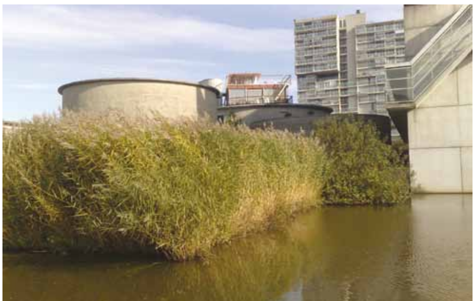
Horizontaal doorstroomd helofytenfilter Oostoever, Amsterdam (1999).
