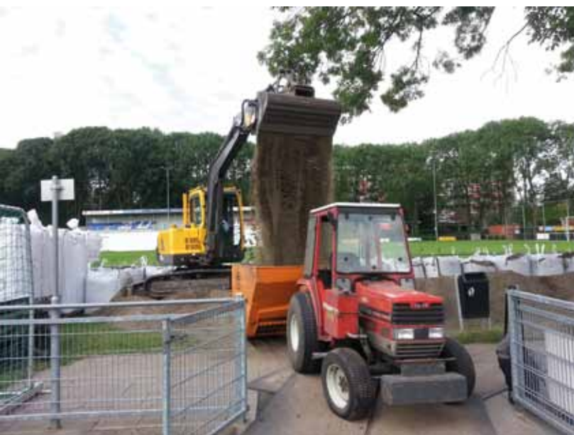
De bak wordt geladen om het zand opnieuw in te strooien.
